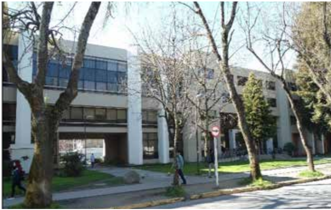
Edificio Central Facultad de Ingeniería.
